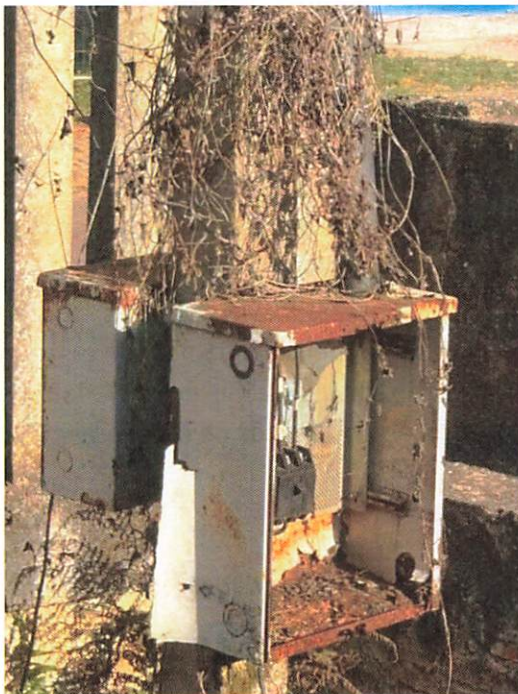
Imagem 36: Padrão de entrada a ser reformado.
